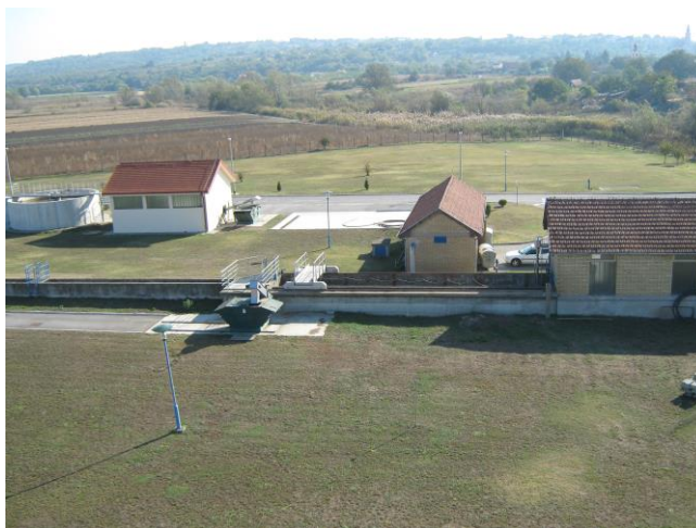
Slika 10 Pjeskolov uređaja za pročišćavanje otpadnih voda grada Belog Manastira
