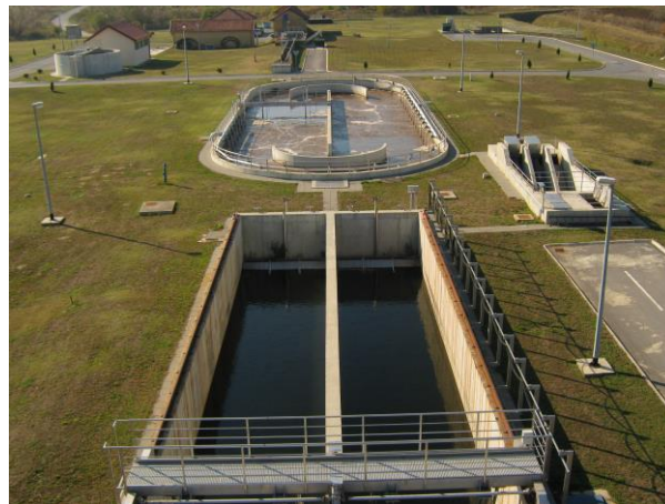
Slika 8 Uređaj za pročišćavanje otpadnih voda u Belom Manastiru
