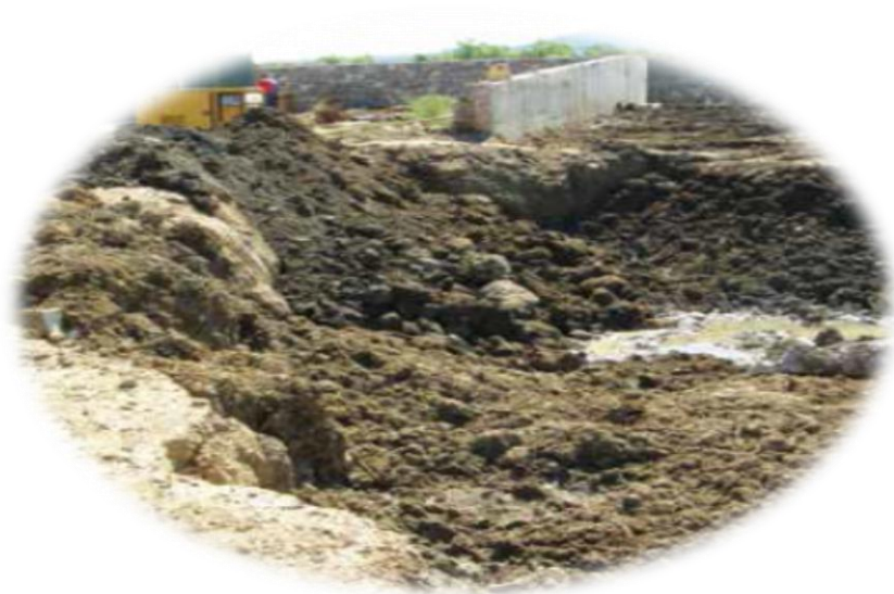
Slika 14. Radovi iskopa i pripreme bazena
