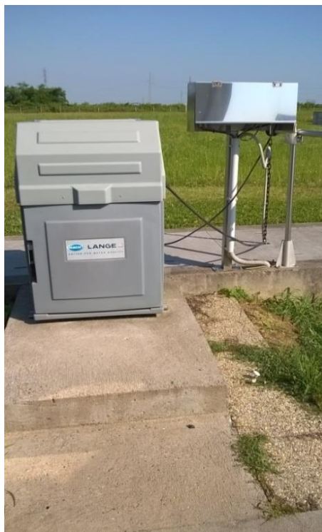
Slika 13 Uzorkivač izlaz na UPOV Našice
