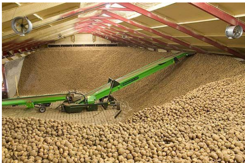
Slika 8 Skladište krumpira s aktivnom ventilacijom
