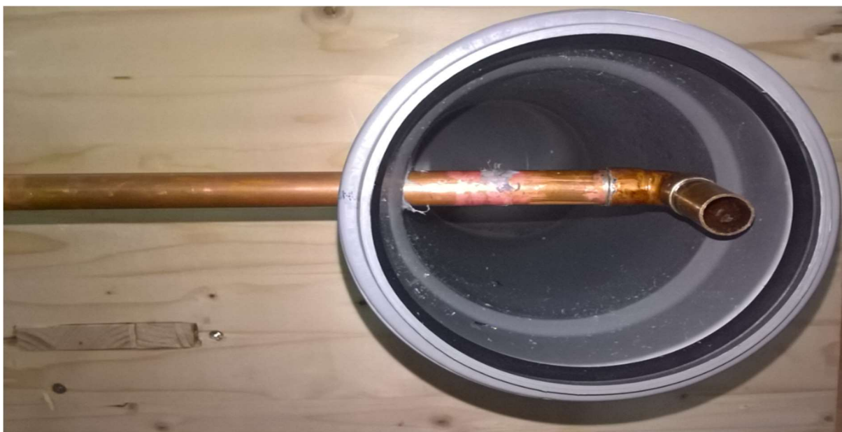
Slika 14 Bakreno koljeno lemljeno legurom cinka i kositra
