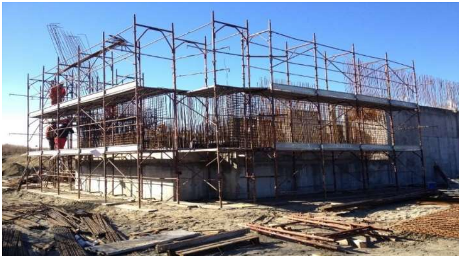
Slika 10. Izgradnja primarnog taložnika u drugoj fazi izgradnje UPOV-a grada Osijeka (Vodovod-Osijek d.o.o., 2017)
