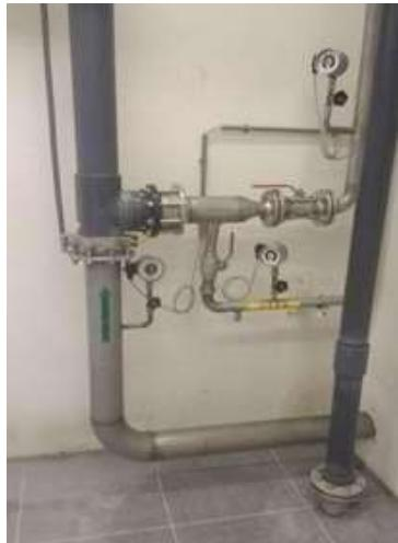
**Slika 6.** Regulaciono mjesto za dovod ozona i sirove vode u komoru za predozonizaciju u pogonu tvrtke Vodovod d.o.o. Slavonski Brod
