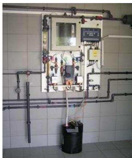
**Slika 13.** Uređaj za proizvodnju i doziranje klorova dioksida u pogonu tvrtke Vodovod d.o.o.
