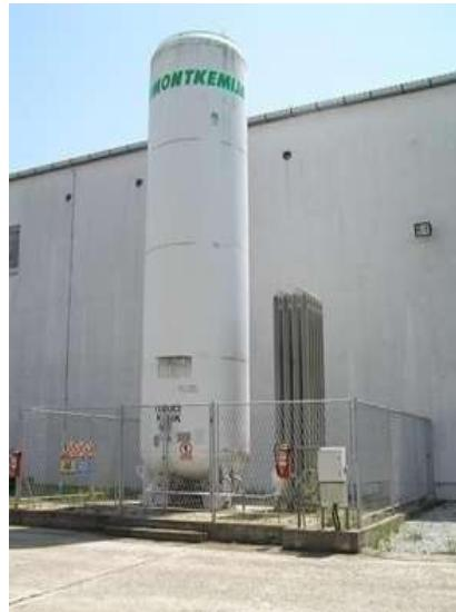
**Slika 11.** Spremnik tekućeg kisika u pogonu tvrtke Vodovod d.o.o. Slavonski Brod
