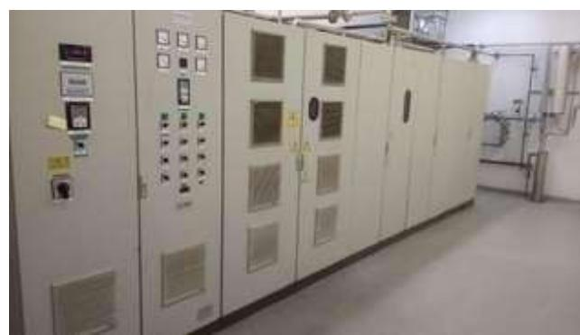
**Slika 10.** Ozon generator u pogonu tvrtke Vodovod d.o.o. Slavonski Brod
