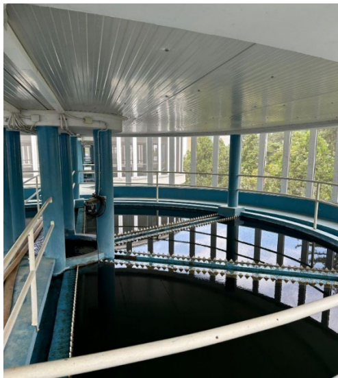
Slika 4 Unutrašnjost taložnika
