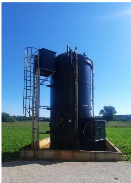
Slika 7 Spremnik polimera na UPOV Đurđevac
