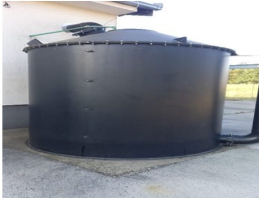
Slika 8 Biofilter za uklanjanje neugodnih mirisa
