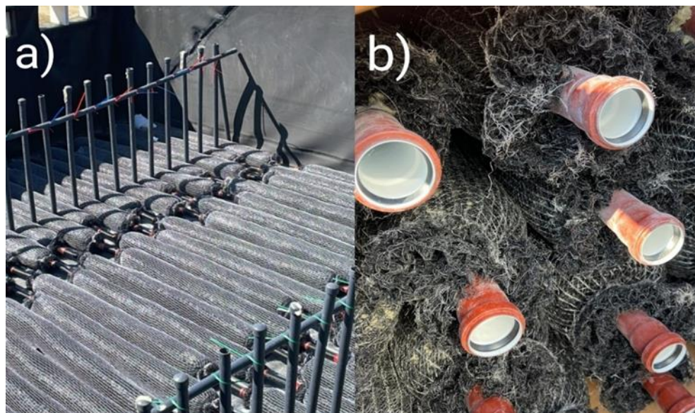
Slika 5 Biološki bazen grada Čazme: a) postavljanje biofiltera u biološkom bazenu u Čazmi b) biofilter (AquaChem, 2020)
