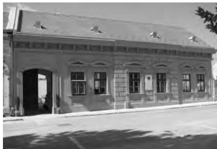
Slika 9. Ružičkina kuća poslije obnove (snimio I. Hubalek, 2007.09.13.)
