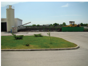
Slika 5. Objekt za dehidraciju i odlaganje mulja Fig. 5. Plant for dewatering and sludge disposal
