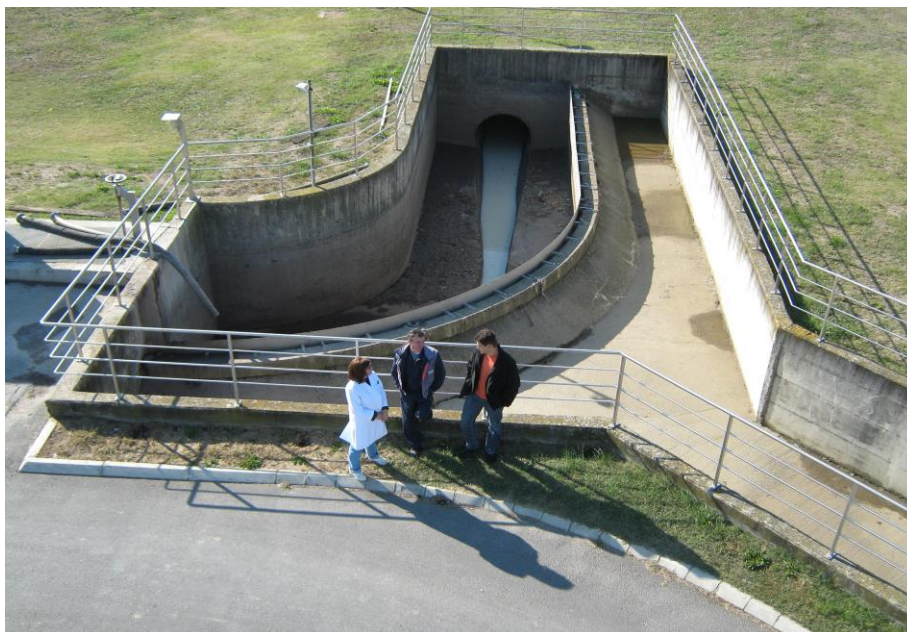
Slika 9 Oteretni prelivni kanal na uređaju za pročišćavanje otpadnih voda grada Belog Manastira
