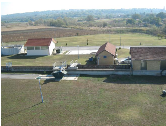
Slika 10 Pjeskolov uređaja za pročišćavanje otpadnih voda grada Belog Manastira
