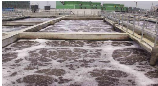
Slika 5 Biološki bazen uređaja za pročišćavanje otpadnih voda u Belom Manastiru
