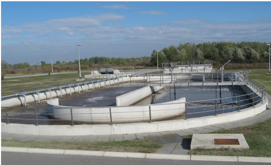
Slika 11 Bioaeracijski bazen uređaja za pročišćavanje otpadnih voda grada Belog Manastira
