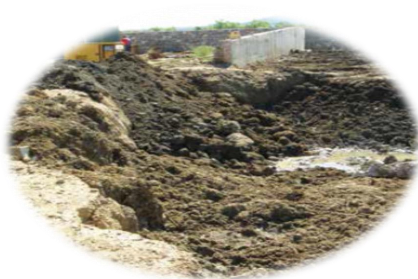
Slika 14. Radovi iskopa i pripreme bazena
