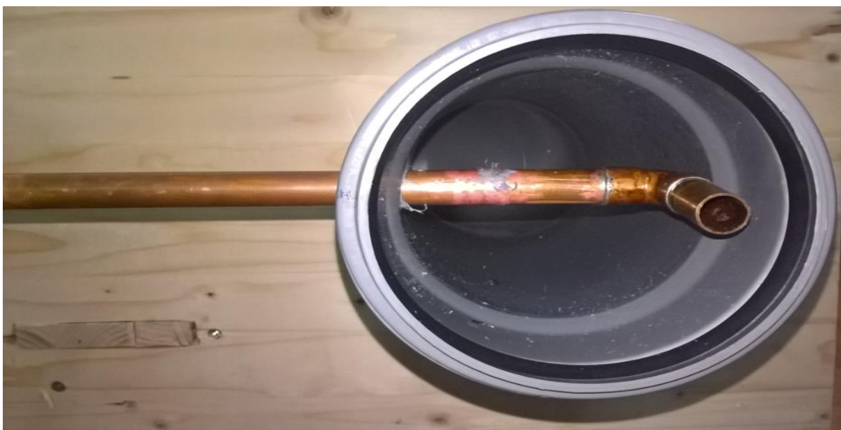
Slika 14 Bakreno koljeno lemljeno legurom cinka i kositra
