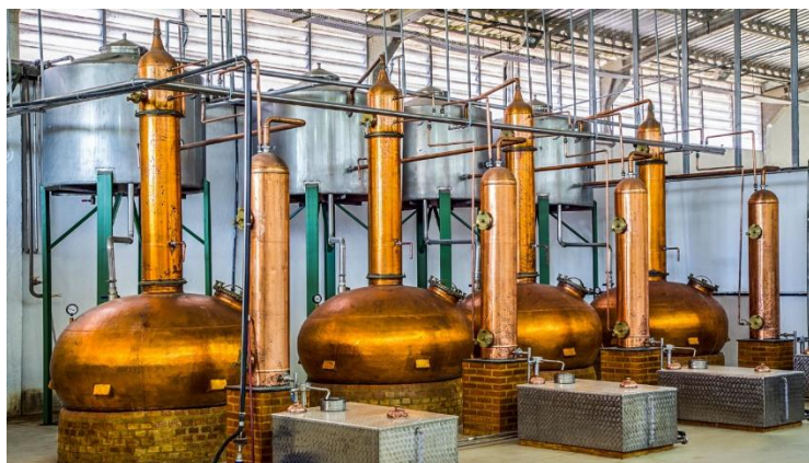
Slika 4 Kotlovi za destilaciju
