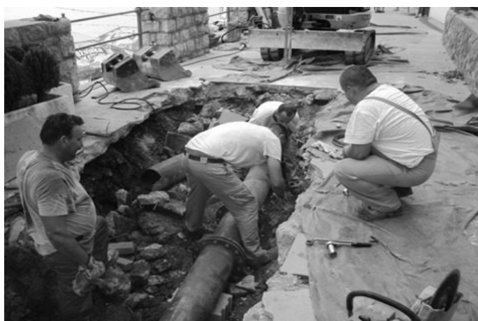
Slika 8. Prikaz sanacije tlačnog voda na šetnici uz hotel Savoy od strane djelatnika Komunalca, d.o.o., Opatija (Izvor: Liburnijske vode, d.o.o., Opatija) Fig. 8. A display of the relief of pressurized wastewater pipeline at the hotel Savoy walkaway carried out by the employees of the company Komunalac d.o.o. Opatija (Source: Liburnijske vode, d.o.o., Opatija)
