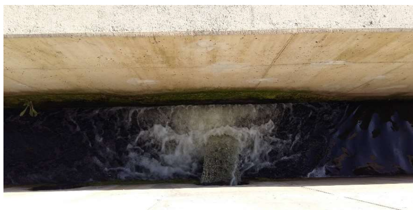
Slika 6. Izlaz pročišćene otpadne vode iz SBR bazena Fig. 6. Efluent of SBR tank
