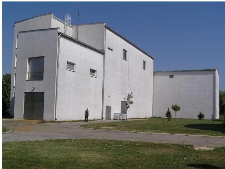
Slika 4. Pogonski objekt za preradu vode tvrtke Vodovod d.o.o. Slavonski Brod
