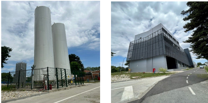
Slika 3 Spremnici čistog kisika i ugljikovog dioksida (lijevo) i zgrada dvostupanjske filtracije s ozonizacijom (desno)
