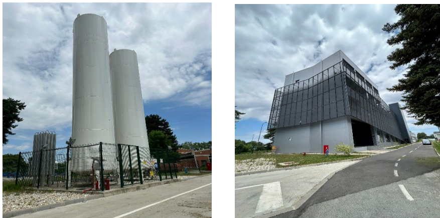
Slika 3 Spremnici čistog kisika i ugljikovog dioksida (lijevo) i zgrada dvostupanjske filtracije s ozonizacijom (desno)
