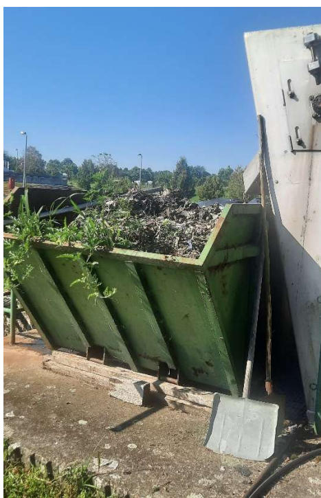
Slika 4 Otpad iz grube rešetke na UPOV Đurđevac
