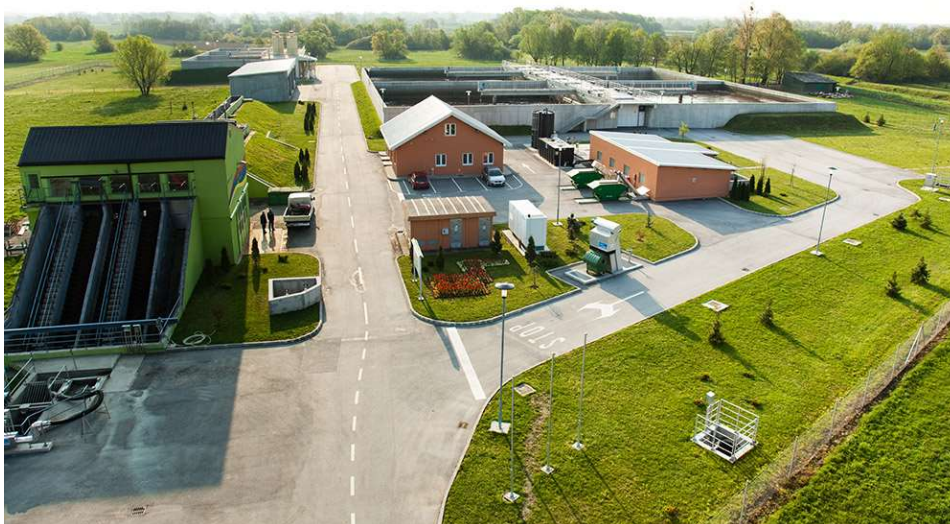
Slika 1 UPOV Herešin (Koprivnica) ( www.kcvođe.hr/upov/ )
