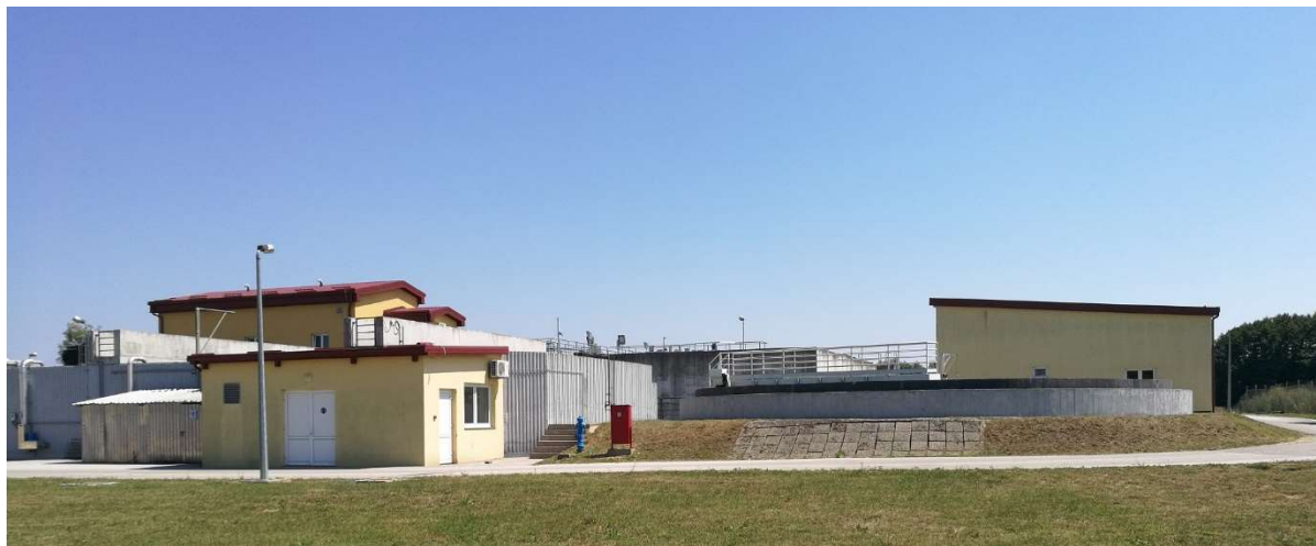
Slika 2 UPOV Đurđevac ( https://komundju.hr/odvodnja-i-prociscavanje/ )
