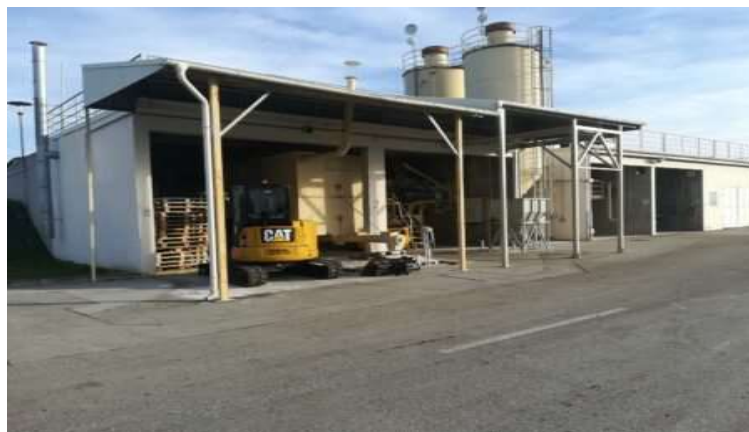
Slika 12 MID - MIX postrojenje na UPOV Koprivnica ( www.kcvode.hr/postrojenje/ )
