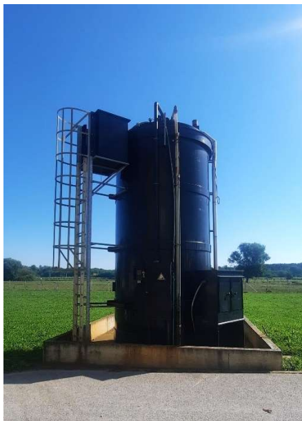
Slika 7 Spremnik polimera na UPOV Đurđevac
