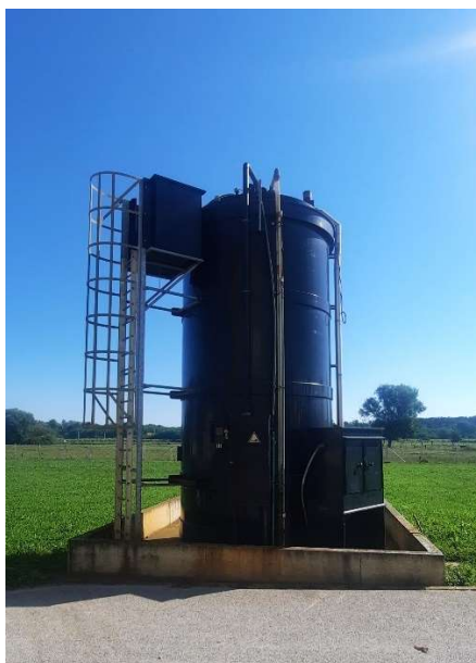
Slika 7 Spremnik polimera na UPOV Đurđevac
