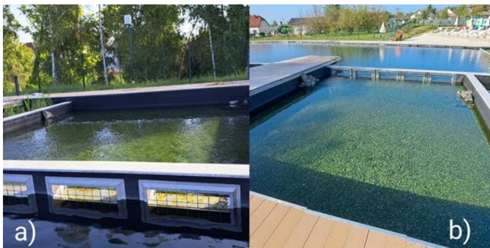
Slika 3 Biološki bazen grada Čazme: a) filtracijska rešetka b) filtracijska zona
