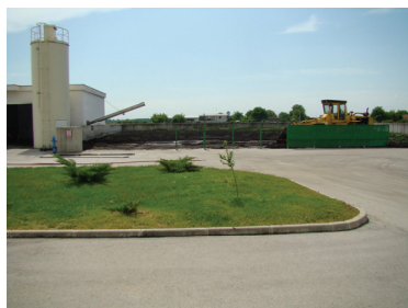
Slika 5. Objekt za dehidraciju i odlaganje mulja Fig. 5. Plant for dewatering and sludge disposal
