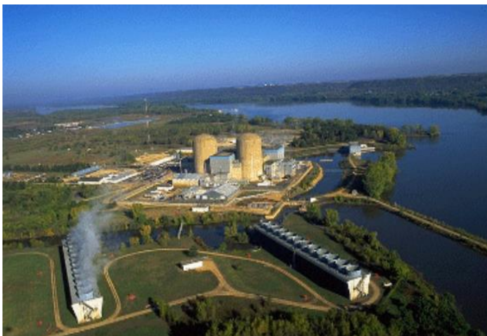
Slika 11. Rashladni tornjevi s prisilnim strujanjem zraka (Izvor: Prelec, 1994.)
