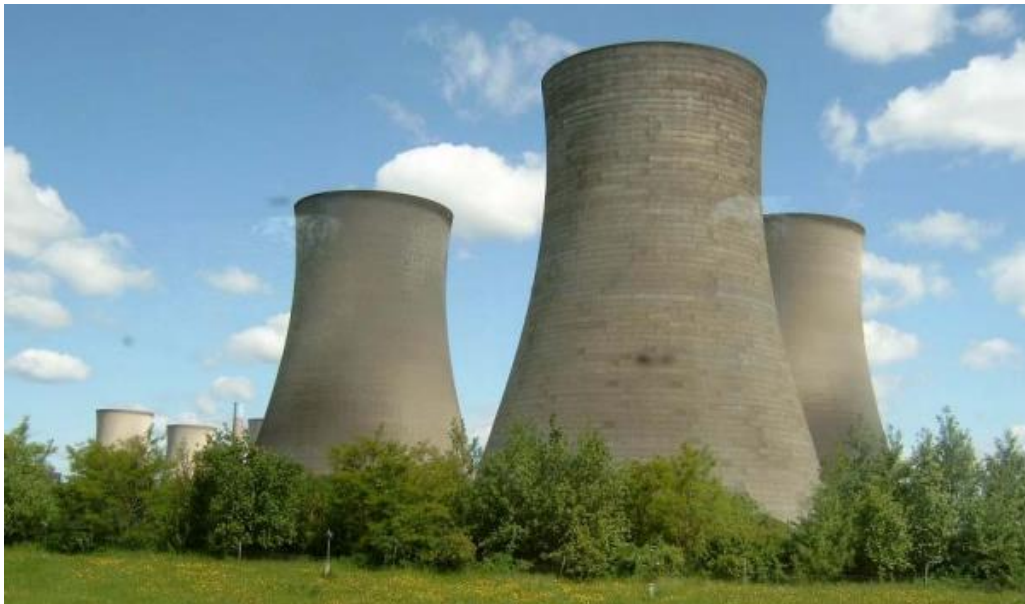
Slika 8. Rashladni tornjevi s prirodnim strujanjem zraka (Izvor: Prelec, 1994.)
