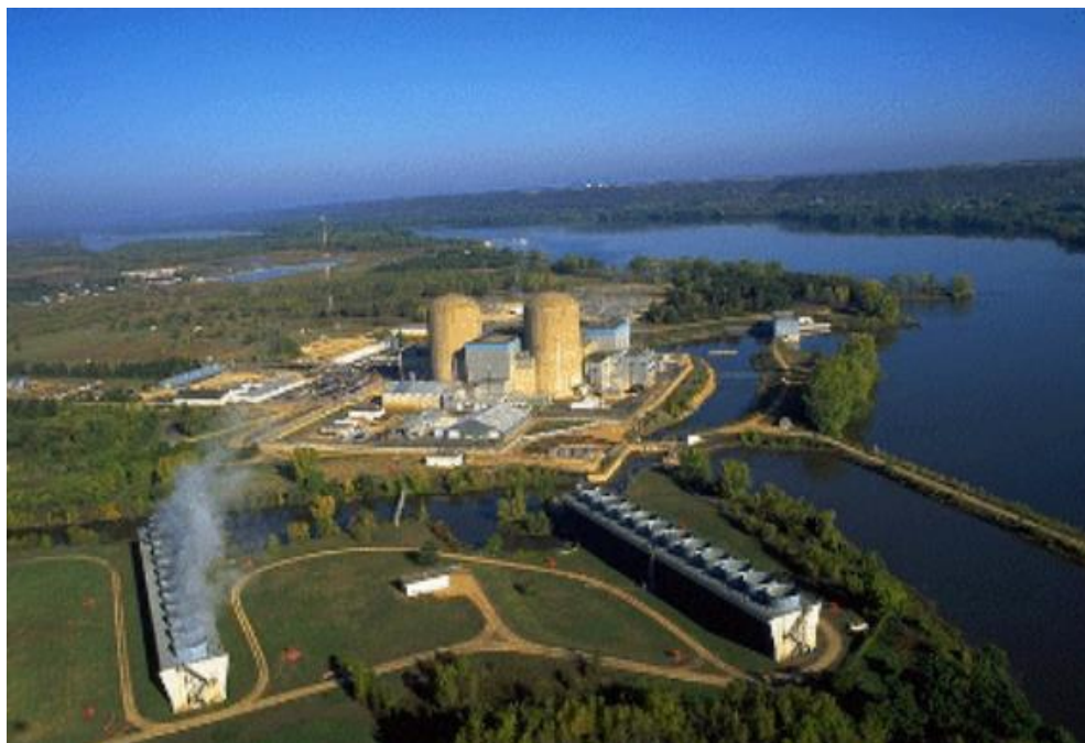
Slika 11. Rashladni tornjevi s prisilnim strujanjem zraka (Izvor: Prelec, 1994.)
