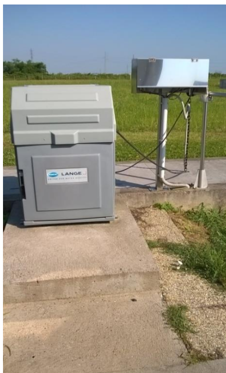
Slika 13 Uzorkivač izlaz na UPOV Našice
