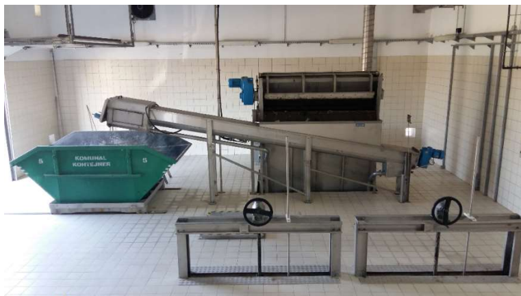
Slika 1. Sustav grube rešetke Fig. 1. Grid's sewer line
