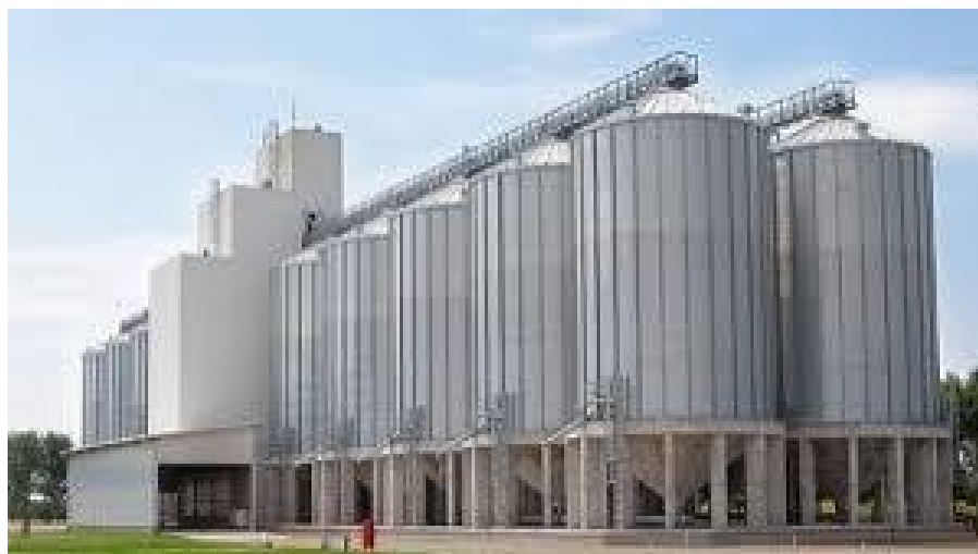
Slika 10 Protočna sušara sa silosima
