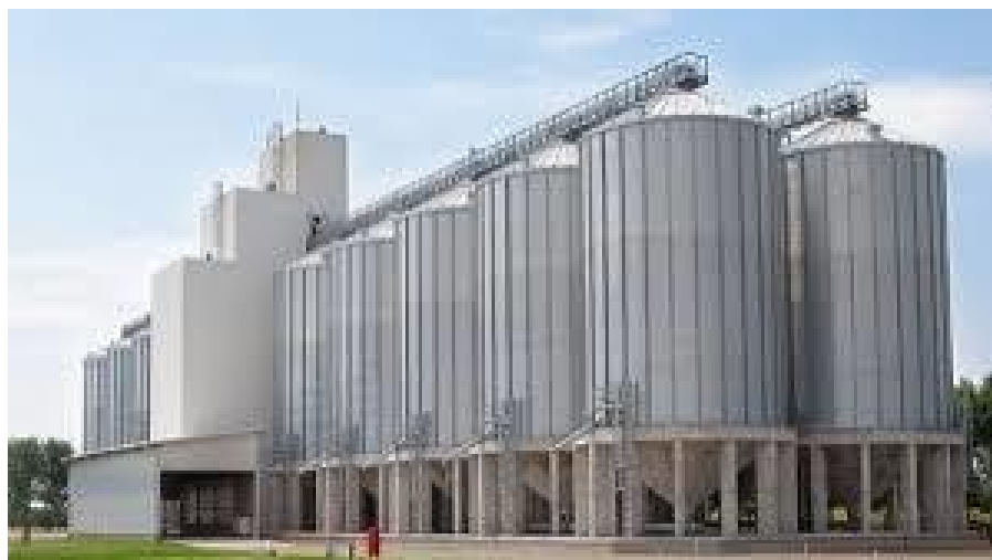
Slika 10 Protočna sušara sa silosima
