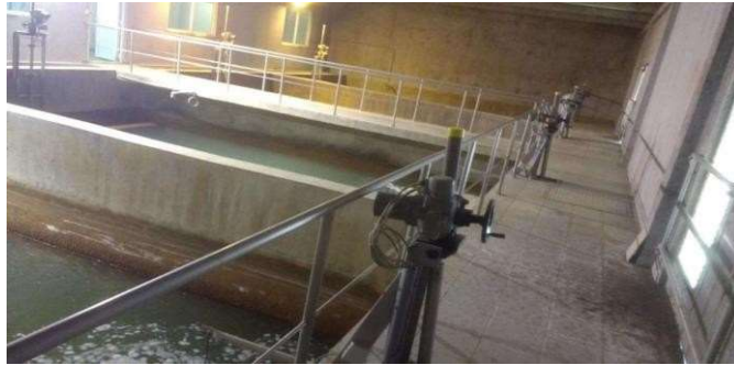
Slika 7. DUAL - MEDIA filtarska polja u pogonu tvrtke Vodovod d.o.o. Slavonski Brod
