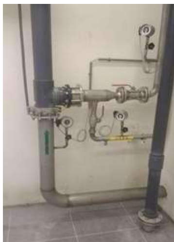
Slika 6. Regulaciono mjesto za dovod ozona i sirove vode u komoru za predozonizaciju u pogonu tvrtke Vodovod d.o.o. Slavonski Brod
