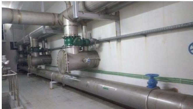
Slika 8. Cjevna galerija ispod filtarskih polja u pogonu tvrtke Vodovod d.o.o. Slavonski Brod
