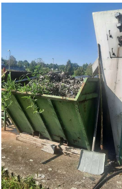
Slika 4 Otpad iz grube rešetke na UPOV Đurđevac
