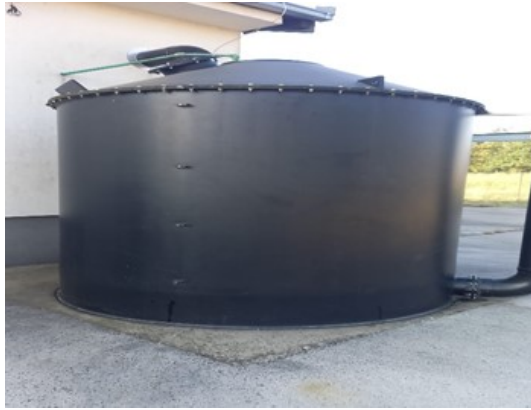
Slika 8 Biofilter za uklanjanje neugodnih mirisa
