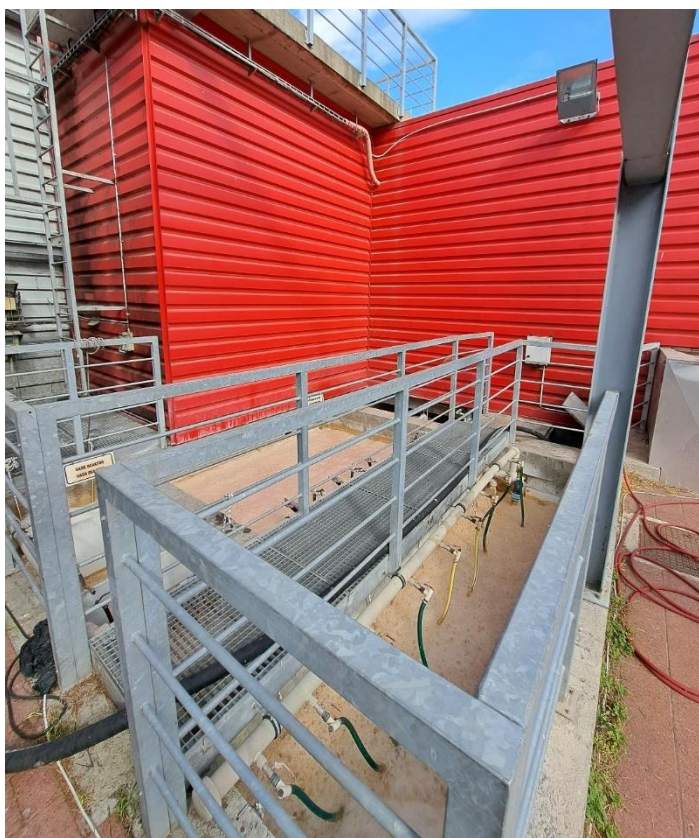
Slika 9 Postrojenje za pročišćavanje otpadnih voda konditorske industrije
