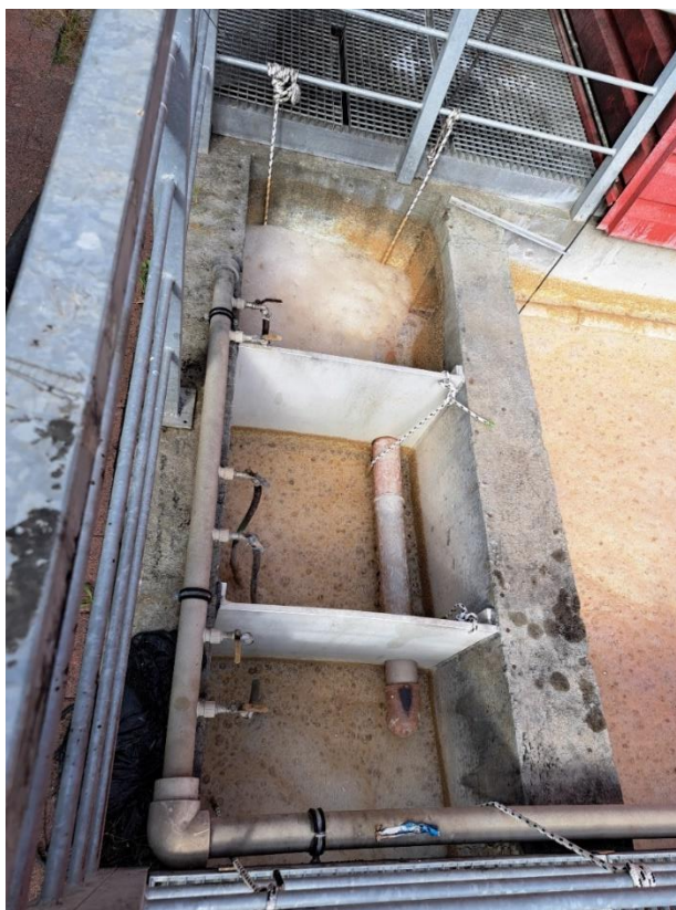
Slika 11 Anaerobni UASB reaktor uređaja za pročišćavanje otpadnih voda konditorske industrije
