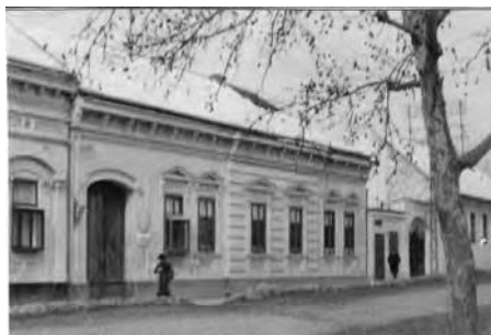
Slika 2. Ulično pročelje Ružičkine kuće
