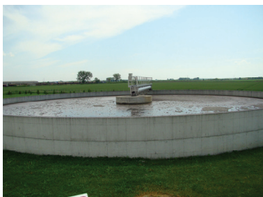
Slika 4. Sekundarni taložnik Fig. 4. Secondary settlement tank
